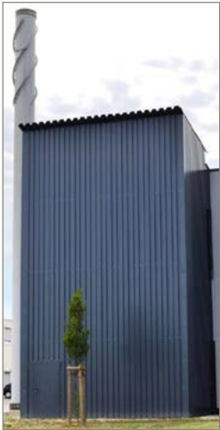
Abb. 34: Beispiel eines eingehausten Pelletsilos zur Außenaufstellung
